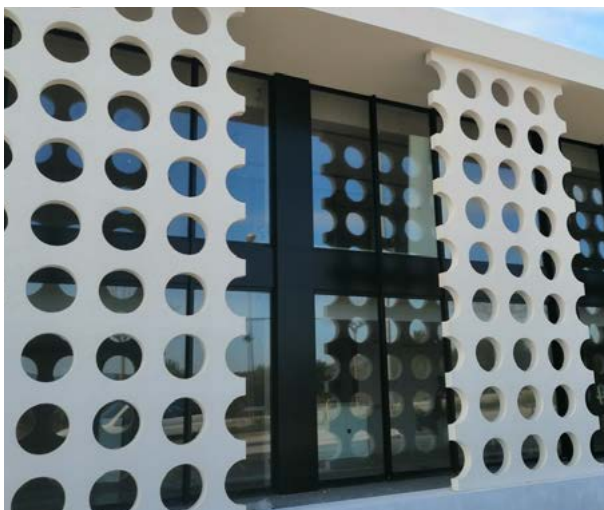
Celosías de las nuevas oficinas del GRUPO BAUZA prefabricadas con el sistema MOLDU3
