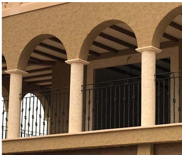
Forros de columnas y arcos prefabricados MOLDU3. Hotel Creu de Tau Art & Spa.
